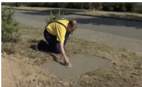
Fläche glätten - halten Sie diese etwas unter- halb des Umgebungsniveaus
