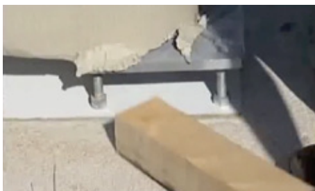
Pylon mithilfe von Kanthölzern aufsetzen und ausrichten
