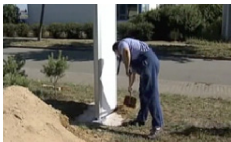
Nach erfolgter Verschraubung Fundament auf Umgebungsnive- au auffüllen
