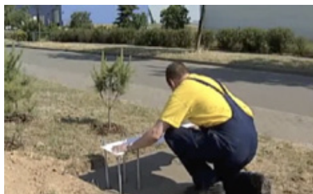
Montageset in das noch feuchte Fundament ein- setzen
