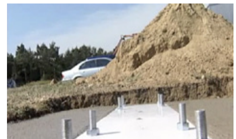
Zustand mit eingesetztem Fundament
