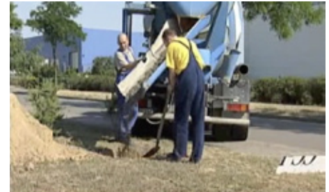
Beton einfüllen
