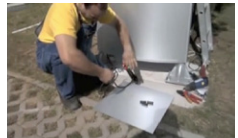
Bei Beleuchtung das unten ausgeführte Kabel fachgerecht anschießen (Elektriker)
