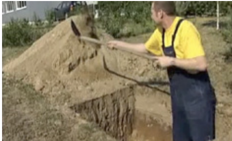
Fundament ausheben
