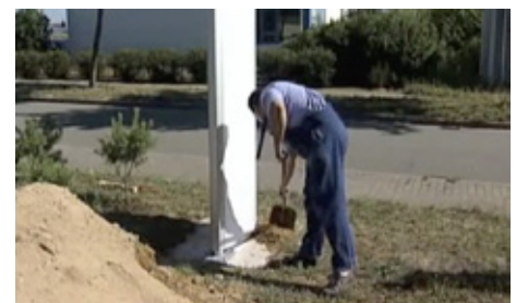
Ein letztes mal mit Sand das Erdreich auf das gewünschte Niveau bringen und glätten
